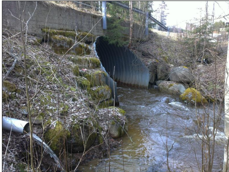
Turkimusojan silta, N 6842842 E 297058, suunta 345
